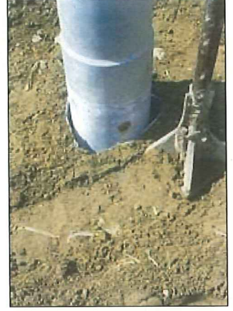
4 シグナル周辺地盤を発生残土で埋戻し、転圧する。
