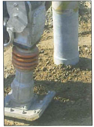
6 残土あるいはモルタル等を表層へ埋戻し完了。
