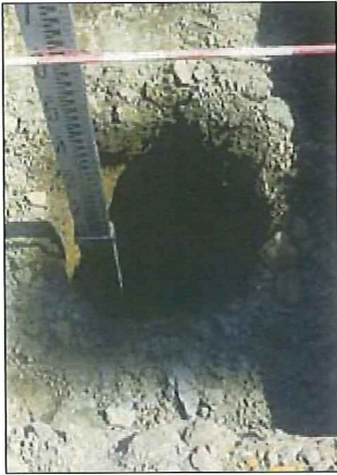
1 試験堀(□700×600)及び支柱建込分を掘削する。
