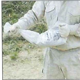
5 アンカーゲルを流し込む。(深さ30cm程度) アンカーゲルは5分前後で硬化し、支柱は完全に固定される。
