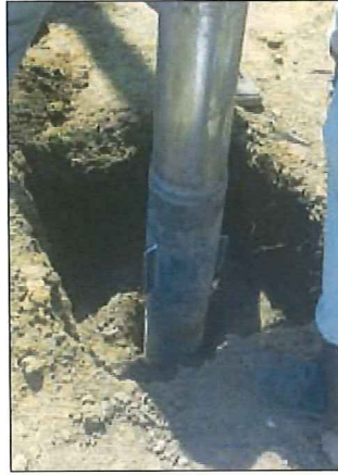
2 支柱の建込後、シグナル設置位置にねじれ防止機能を付与。
