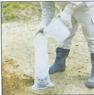
5 アンカーゲルを流し込む。(深さ30cm程度) アンカーゲルは5分前後で硬化し、支柱は完全に固定される。
